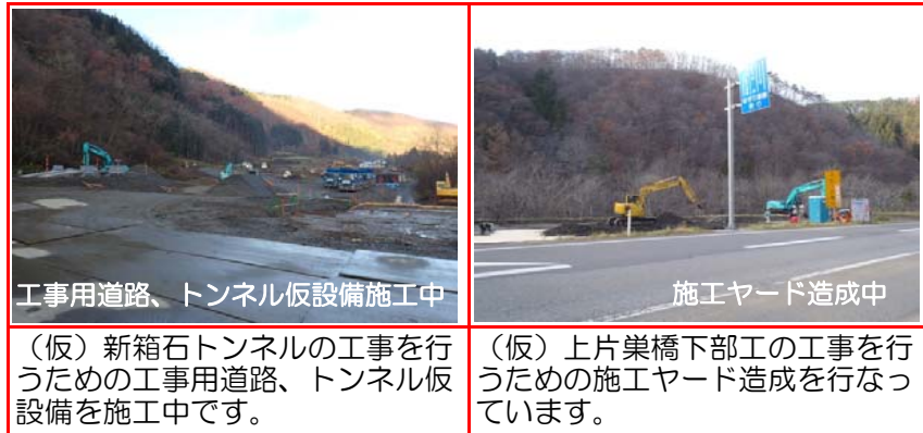
⑥施工：安藤・間
